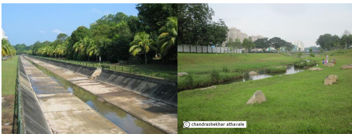
10. ábra Vízfolyásmeder visszaállítás természetes formába (Forrás: http://chandrashekarasandprints.wordpress.com/2012/05/11/restoring-an-urban-river-bed-to-its-natural-eco-system-a-singapore-experiment/ )
