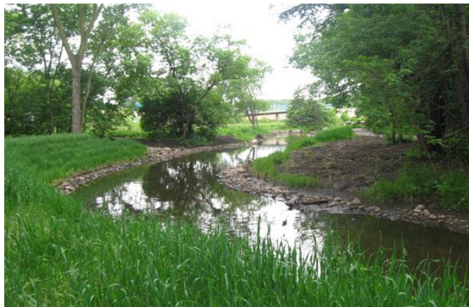
13. ábra Vízpart stabilizáció (Forrás: http://www.goldenvalleymn.gov/surfacewater/stream-bank-stabilization.php )
