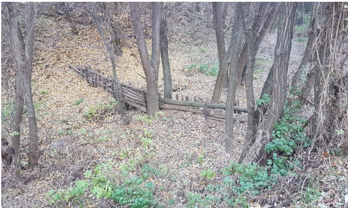
21. ábra Szivárgó rönkgát Püspökszilágyon (saját fotó)
